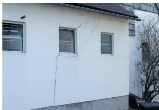
Setzungsrisse an der Außenwand eines angebauten Raumes
