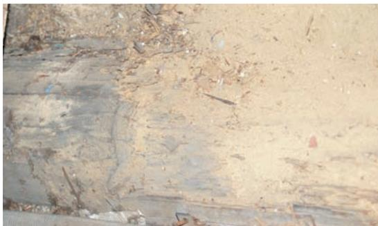
Befall durch den Hausbockkäfer – die Beschädigungen und Fraßgänge sind bereits deutlich sichtbar.
