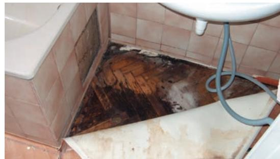
Wasserschaden aufgrund eines beschädigten Badewannenablaufes
