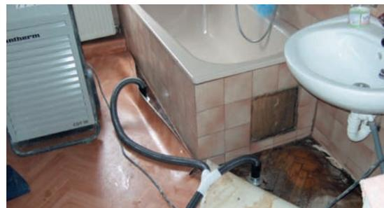
Trocknung des Bodenaufbaues mittels Seitenkanalverdichter und Kondensattrockner
