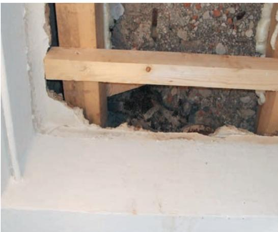
Verstärken eines Deckenbereiches durch das Einbauen zusätzlicher Träme
