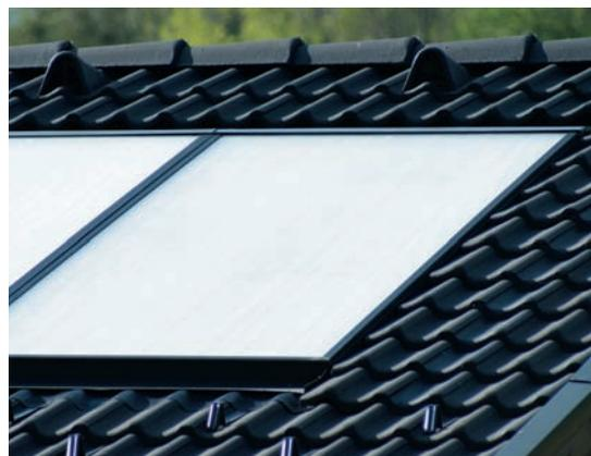
Sonnenkollektor in Form einer „In-Dach-Montage“: Hier werden die Kollektoren nicht aufgeständert, sondern ersetzen die Dachdeckung.
