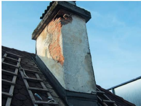
Durch Verwitterung und Frost beschädigter Kaminkopf
