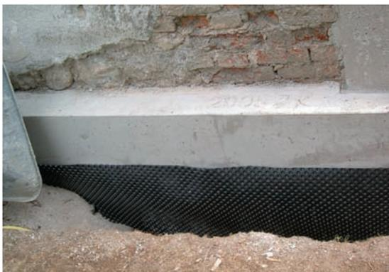
Abdichtung der Kellerwand von außen durch das Vorsetzen einer Dichtbetonschale
