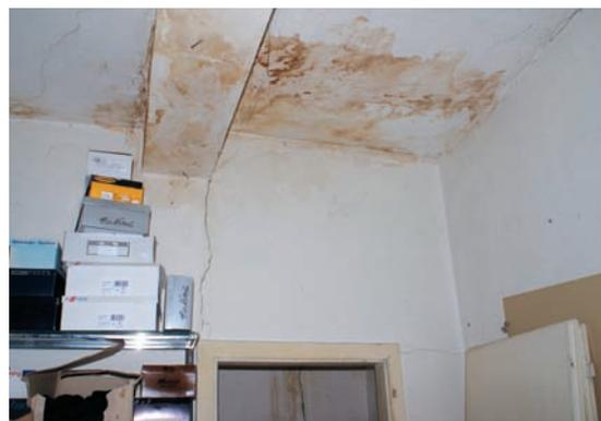
Risse im Bereich eines Unterzuges
