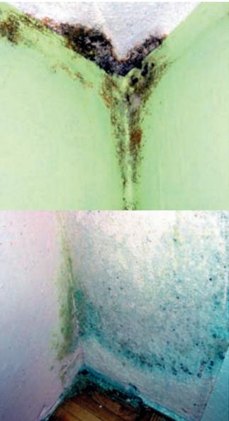
Schimmelbildung an einer Gebäudeaußenecke aufgrund einer Wärmebrücke
