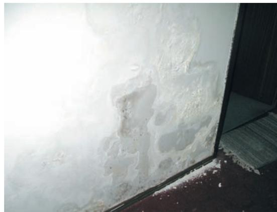
Wasserschaden aufgrund einer beschädigten Verfugung von der Duschanne zu den Wandfliesen
