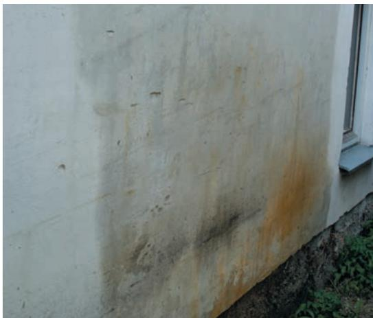
Durchfeuchtung einer Außenwand nach einem Druckwasserleitungsschaden
