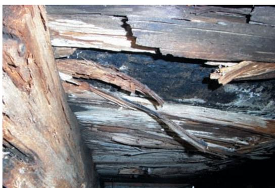
Verfaltung einer Dachkonstruktion
