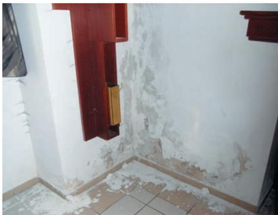
Aufsteigende Feuchtigkeit an einer Erdgeschoßwand (nicht unterkellert)
