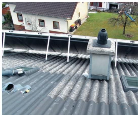
Durch Wind beschädigte Dachplatten
