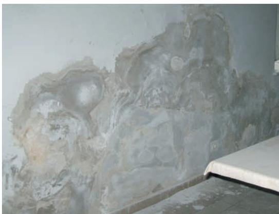
Aufsteigende Feuchtigkeit an einer Erdgeschoßwand (nicht unterkellert)
