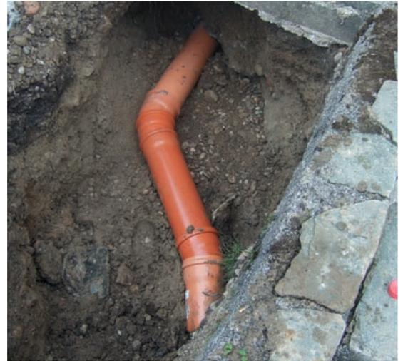
Austausch eines beschädigten Kanalrohres
