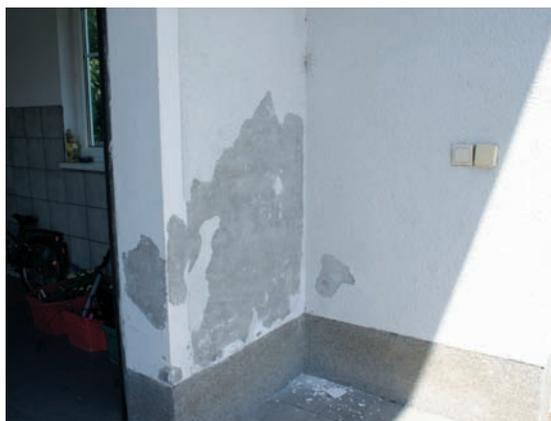
Putzschäden aufgrund aufsteigender Feuchtigkeit in Kombination mit Frost
