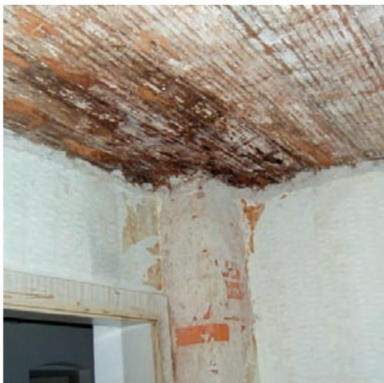
Wasserschaden im Obergeschoß aufgrund einer beschädigten Kaminverblechung
