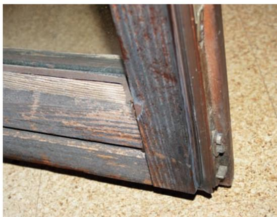
Schäden an der Lackschicht sowie an den Dichtungen einer Holz-Terrassentür
