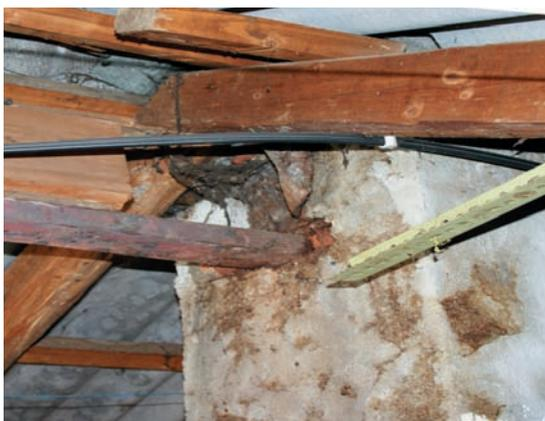
Eine Pfette wurde mittels Stahlprofil direkt auf dem Kamin aufgelagert.
