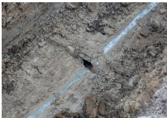
Setzung eines Betonrohres
