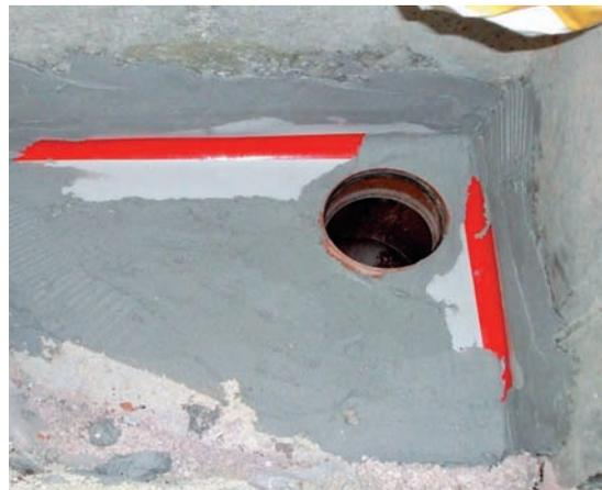
Nachträgliche Abdichtung der Fuge zwischen Bodenplatte und Kellerwand durch Einspachteln eines Dichtbandes
