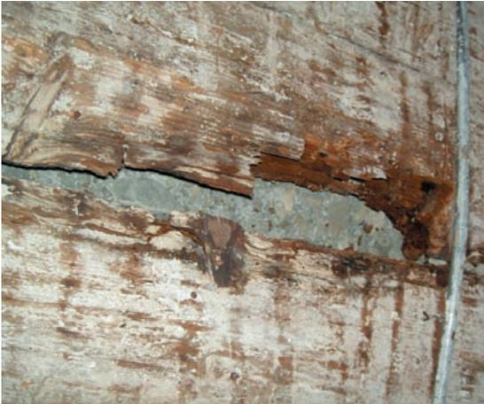
Verfaltung von Deckenbalken aufgrund einer undichten Dachhaut
