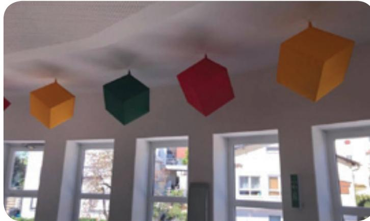
Foto links: Würfelabsorber im Bereich des Stiegenauf-ganges
