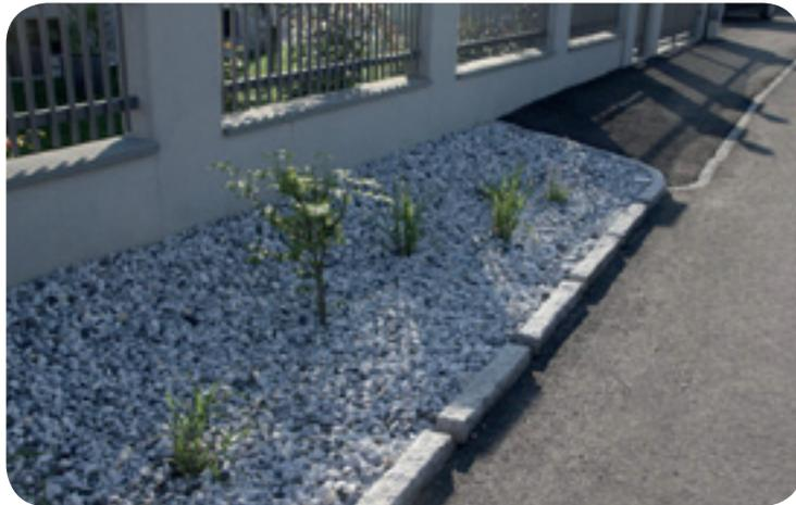
Die Straßenentwässerung wird über Sickermulden mit dem DrainGarden-System passieren
